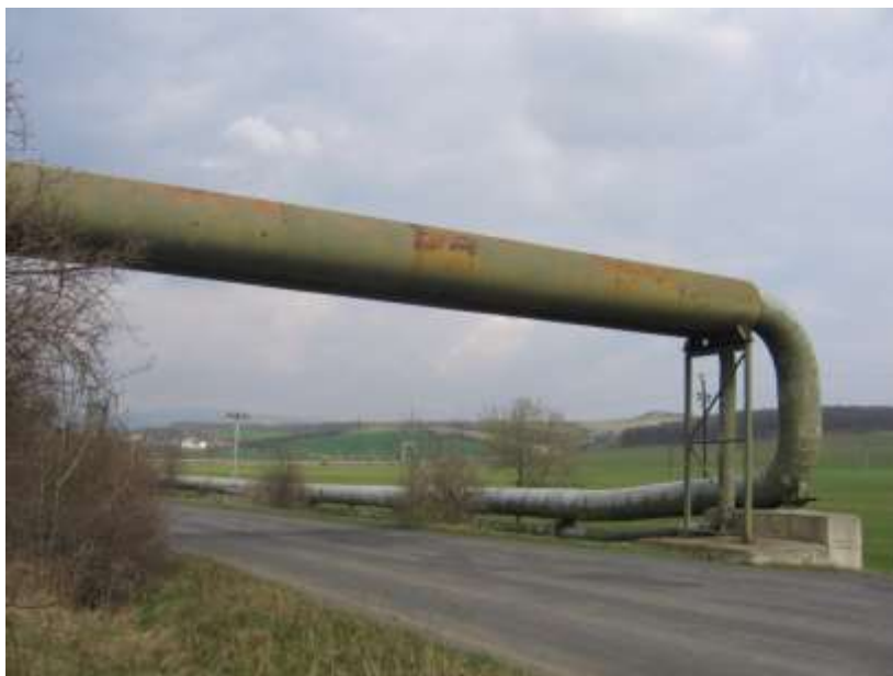
Obr. 3. Krajina mezi Teplicemi a Bílinou v SHP zohydřená nadzemním teplovodem z elektrárny Ledvice do Teplic
